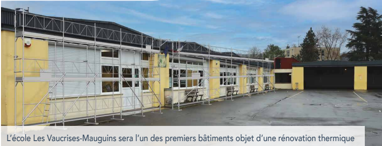
L'école Les Vaucrises-Mauguins sera l'un des premiers bâtiments objet d'une rénovation thermique
