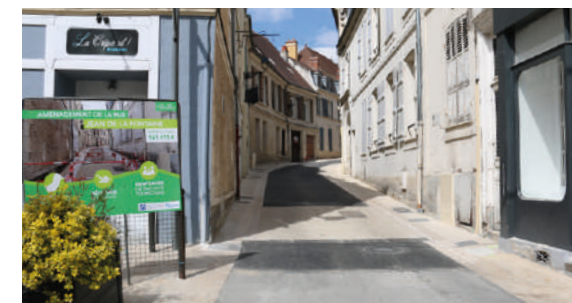
RUE JEAN DE LA FONTAINE EN COURS
