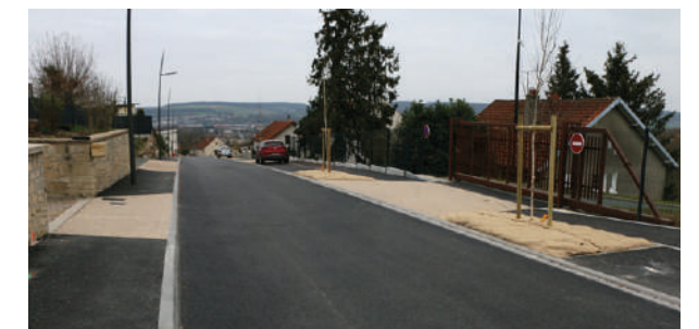
RUE ROGER CATILLON TERMINÉ
